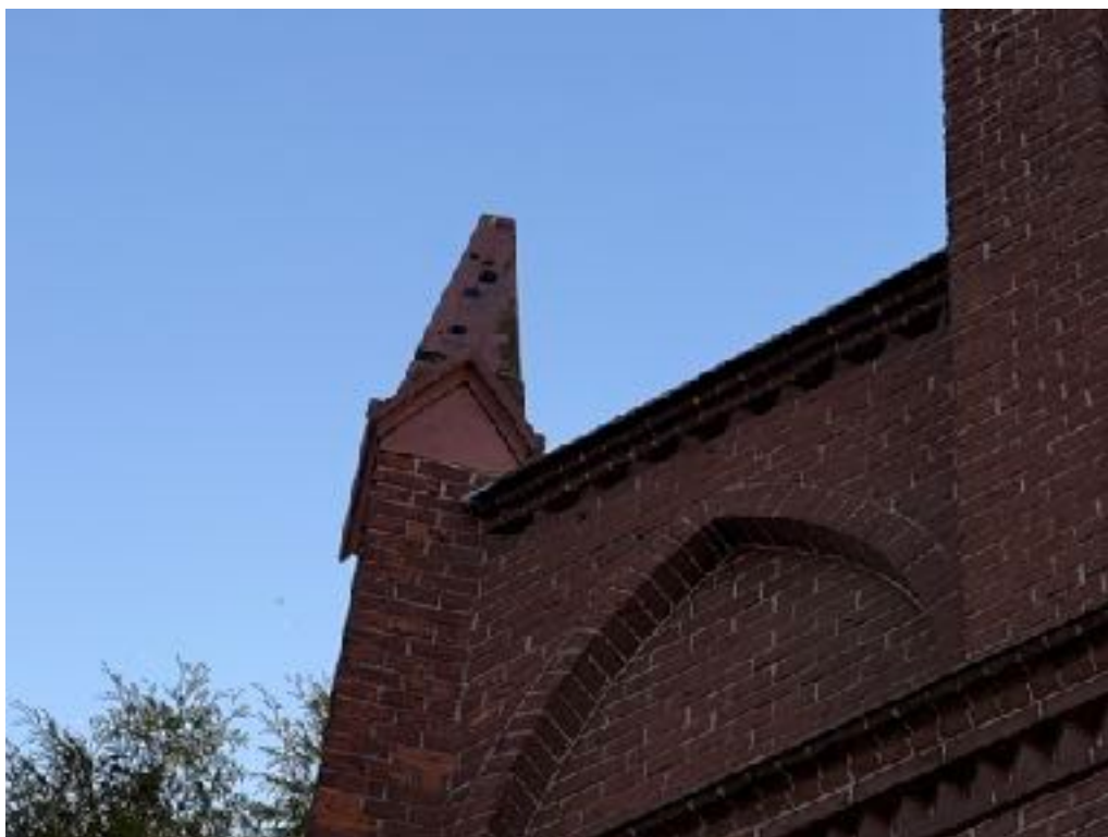
Fot. 15 Zbliżenie na pinakiel bez kwiatonu oraz ze śladami postrzałowymi.
