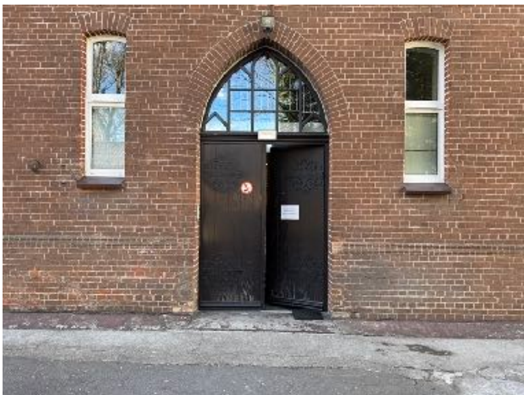
Fot. 12 Zbliżenie na wejście w elewacji wschodniej.
