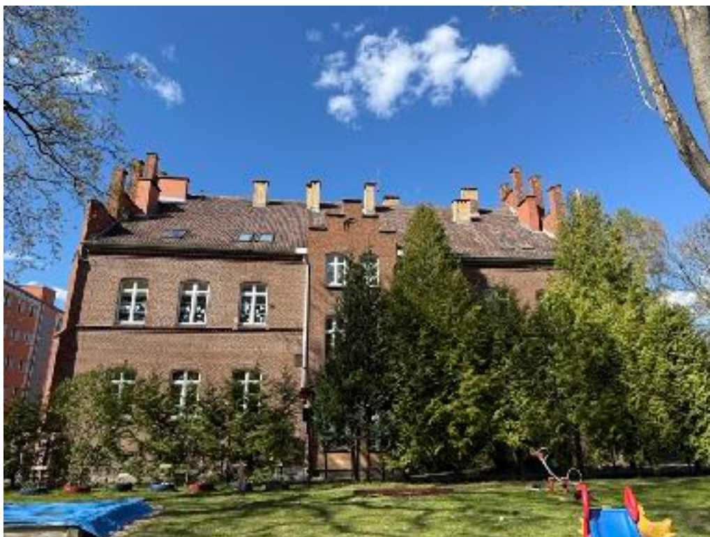
Fot. 17 Elewacja południowa budynku Przedszkola Publicznego w Szczecinku.
