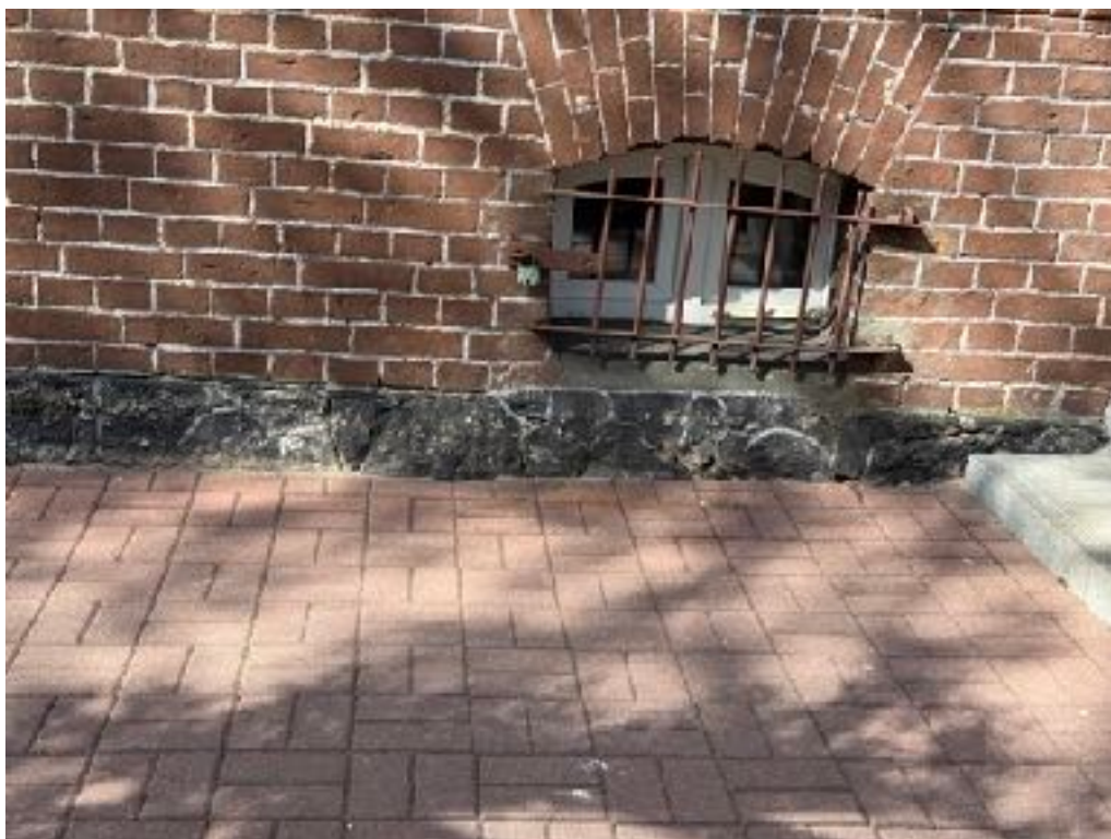
Fot. 21 Ruchoma krata, która należy poddać konserwacji.
