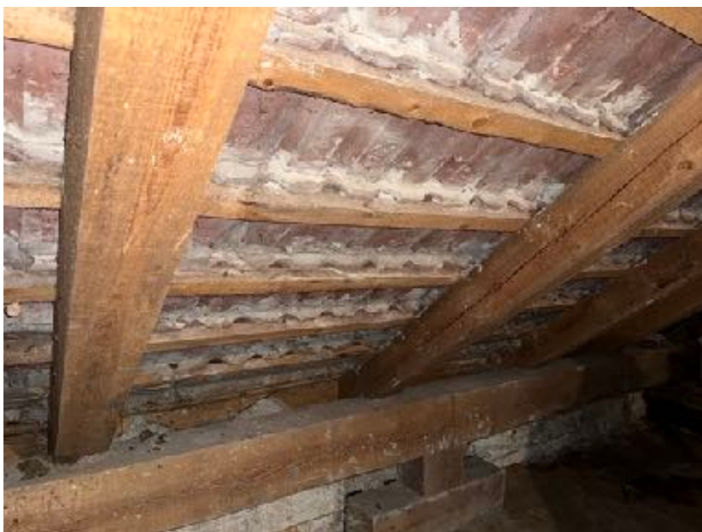
Fot. 28 Zbliżenie na nowsze belki z nieheblowanego drewna.
