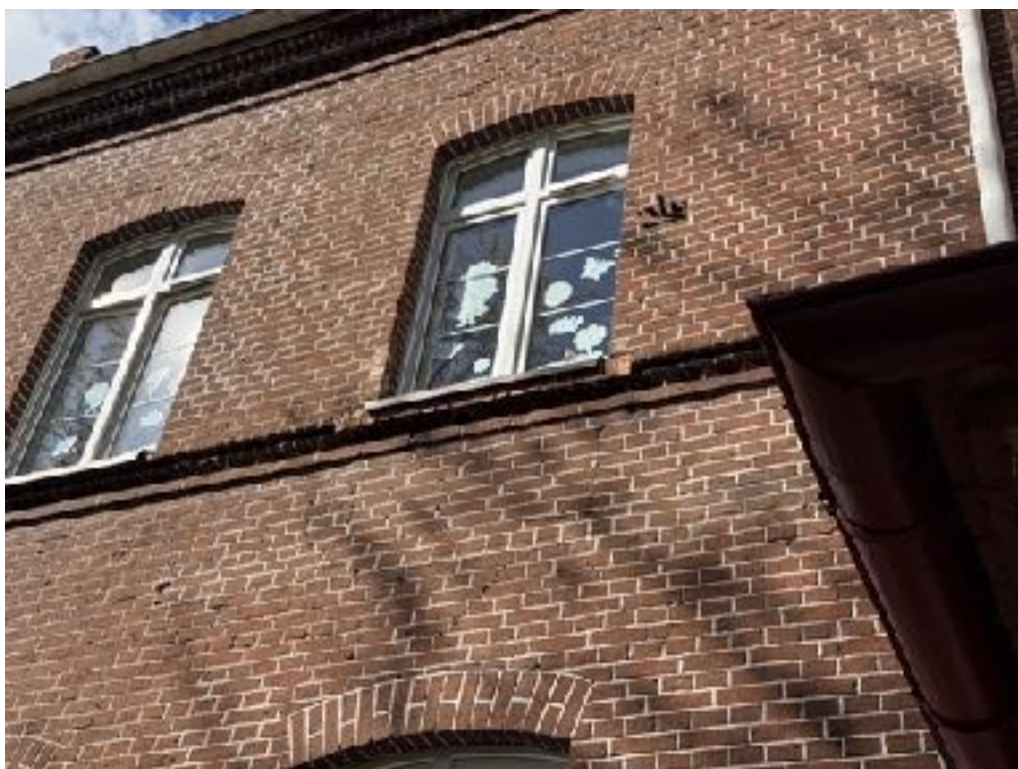
Fot. 18 Zbliżenie na otwór okienny powstały po zlikwidowaniu balkonu.
