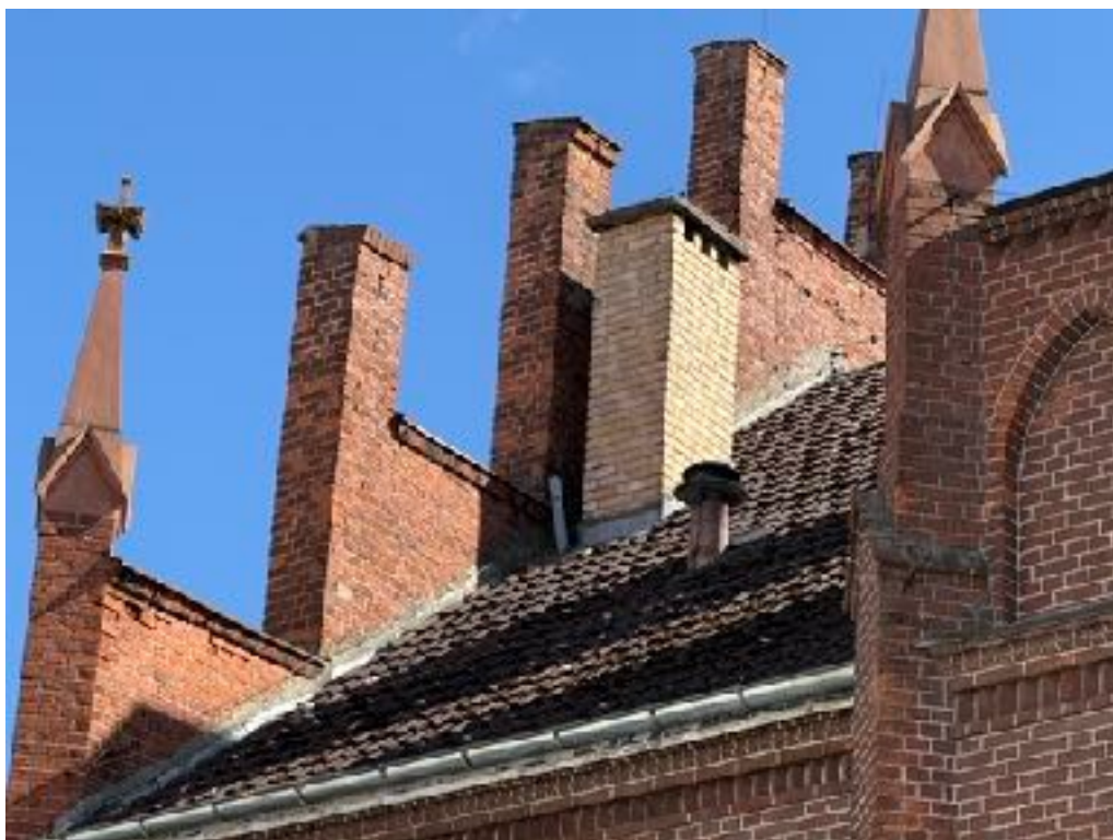
Fot. 5 Widok na dach, tył szczytu oraz komin z żółtej cegły.
