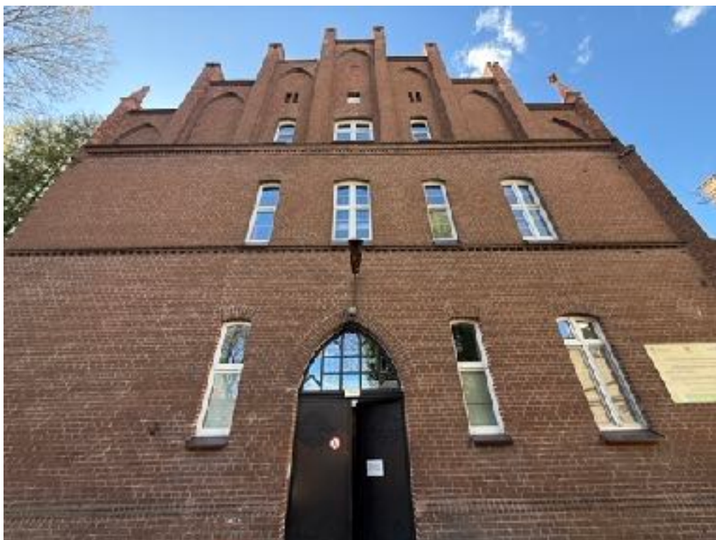
Fot. 11 Elewacja wschodnia budynku Przedszkola Publicznego w Szczecinku.
