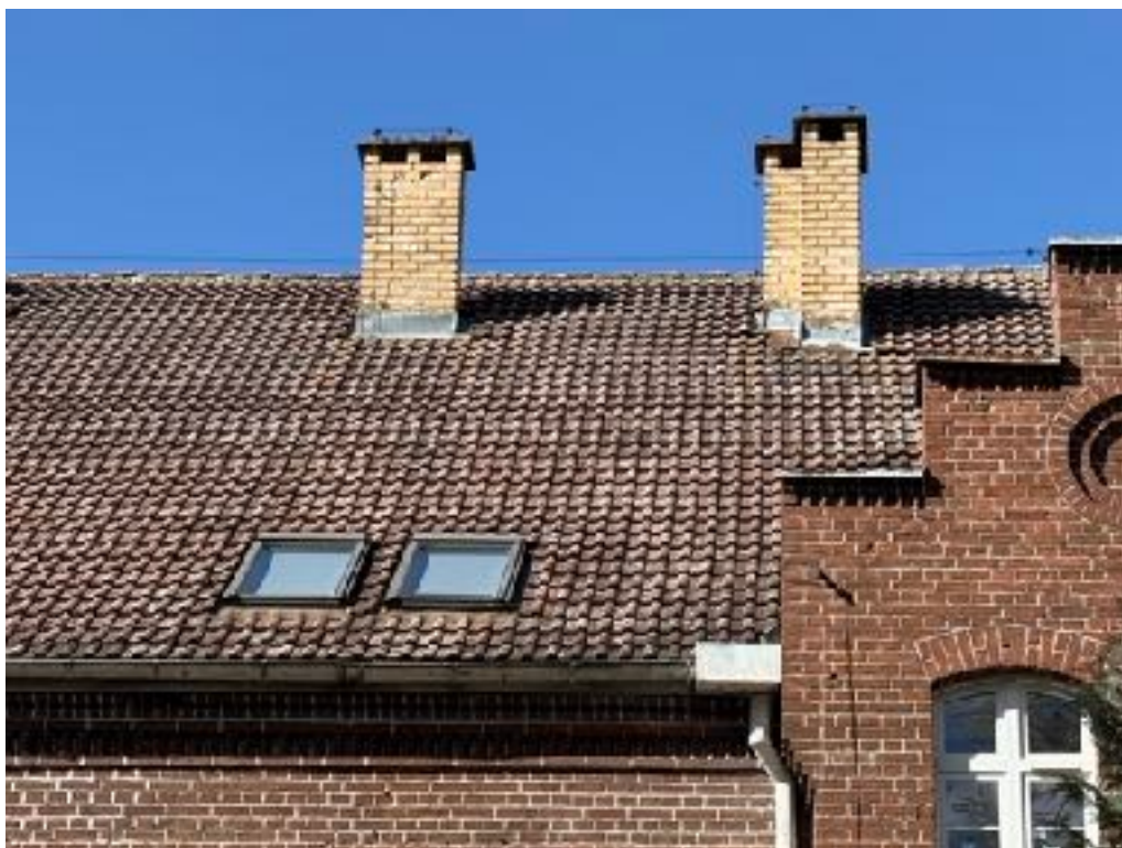
Fot. 23 Zbliżenie na dach od strony południowej.
