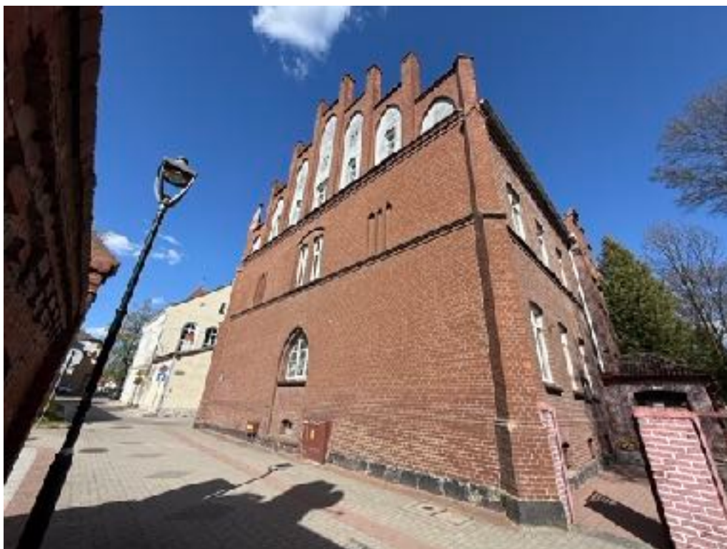
Fot. 7 Elewacja zachodnia budynku Przedszkola Publicznego w Szczecinku.
