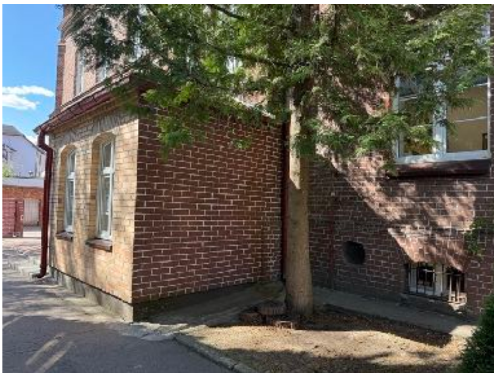
Fot. 19 Wiatrołap z częściowo pomalowaną żółtą cegłą.
