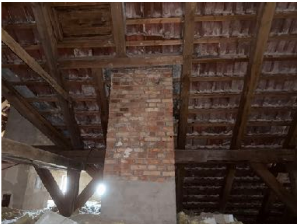
Fot. 25 Widok na więźbę dachową oraz przemurowany komin.
